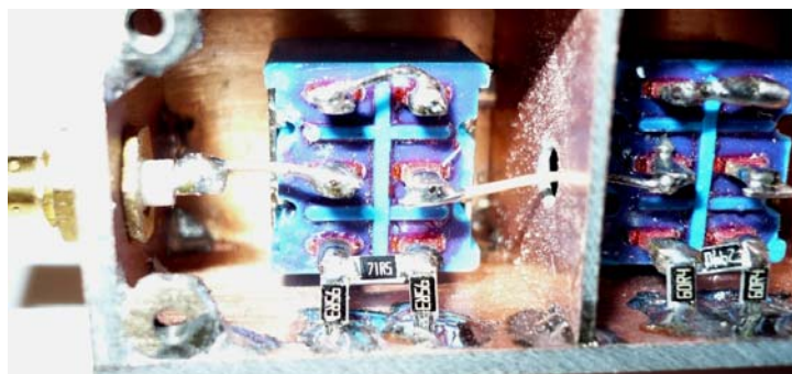
Particolare ingrandito che mostra come sono saldate le resistenze
